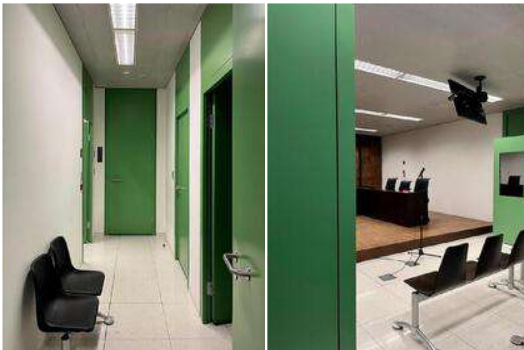
Figura 14. (Da esq. para dir.) Porta de acesso público à sala de audiências e antecâmara de acesso à sala de audiências, que dá acesso às salas de testemunhas, ao corredor de acesso controlado e à ligação com as celas na Cidade da Justiça de Barcelona
